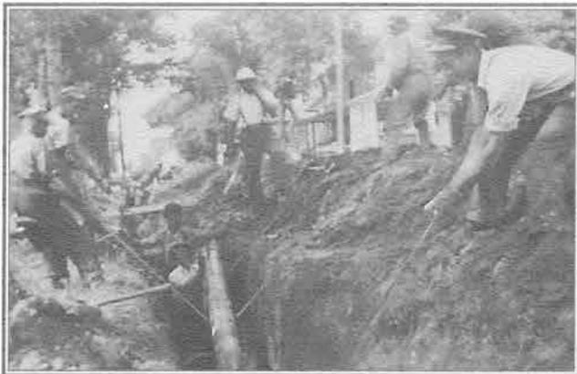
La nombreuse main-d'oeuvre utilise des cables pour descendre les tuyaux.
