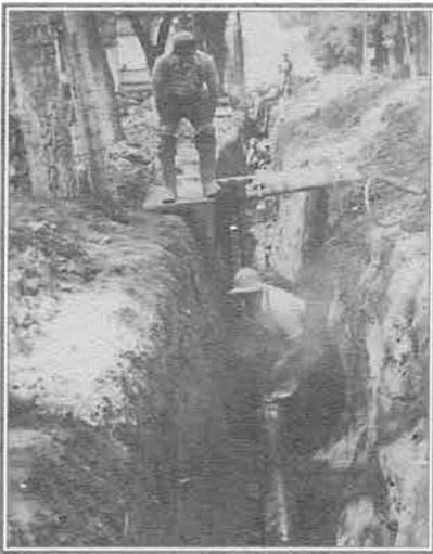
Fin des années 1940, construction d'une partie de réseau d'aqueduc, excavation à la petite pelle et à la chaudière.
